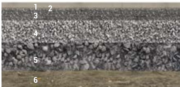
Abbildung 4: Aufbau gebundene Bauweise (Oberbau 1–5)
