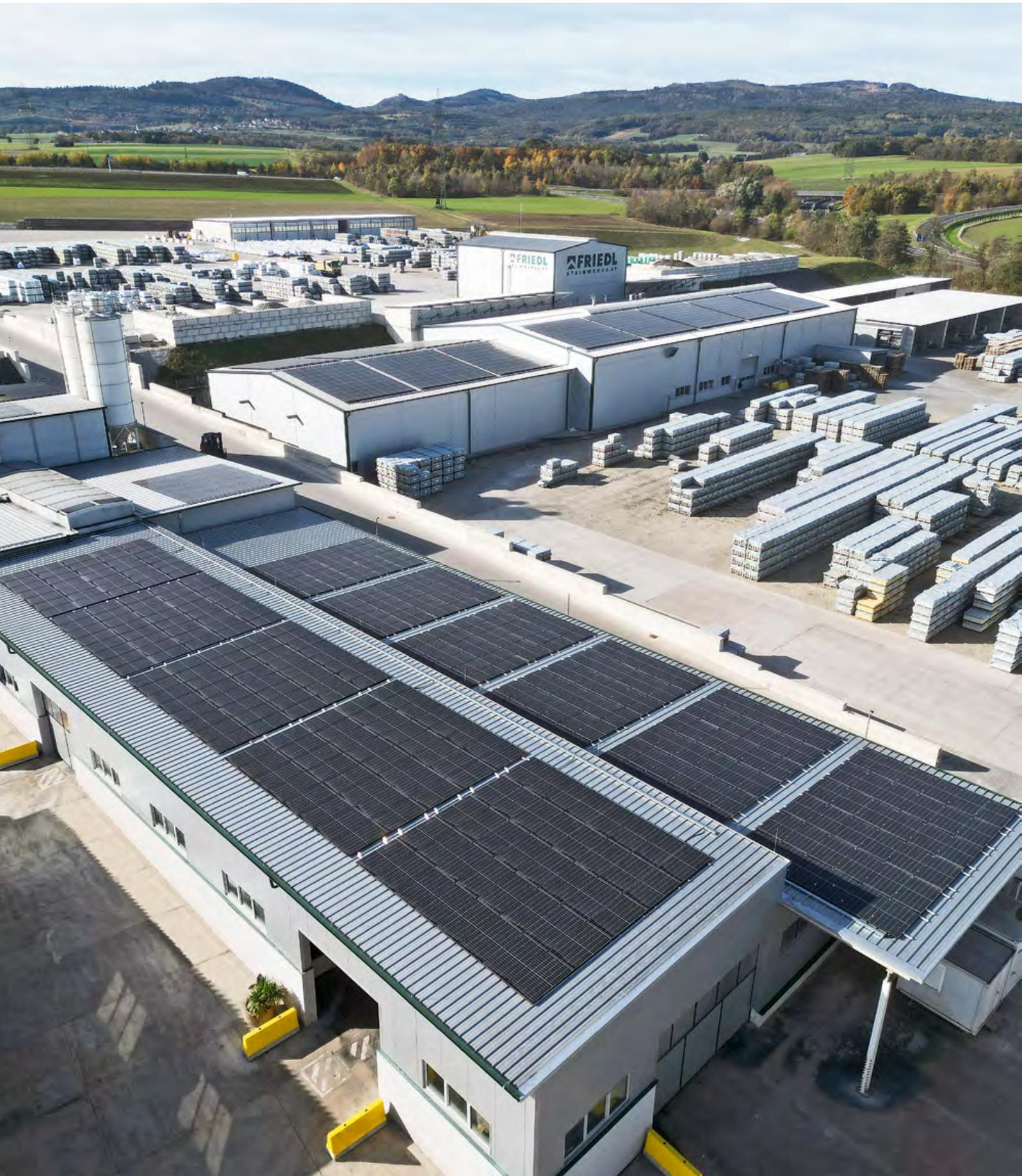
Mit 2.900 m<sup>2</sup> Paneelen wird auf den Hallendächern Sonnenlicht für die Produktion genutzt.
